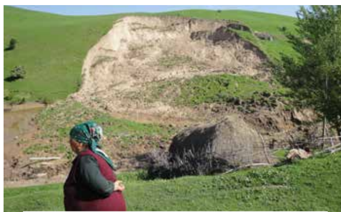
Оползень в Сузакском районе Джалал-Абадской области
