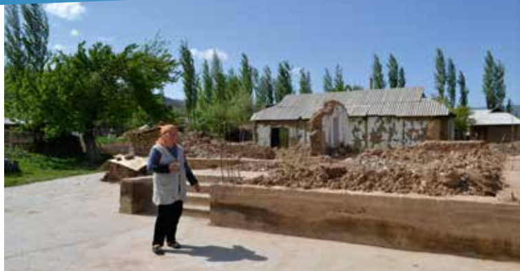
Апрель 2016 года, село Чайчи, Кыргызстан. Исакунова Светлана рассказывает об ее разрушенном доме, который был поврежден в результате землетрясения в 2015 году. (УКГВ ООН / М. Садвакасова)
